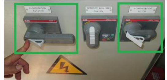
Detalle de los seccionadores cerrados, en condiciones de operación. Close-up of the closed isolation switches under operation conditions.
