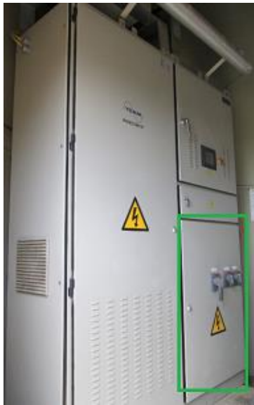
Armario ground. Señalado sobre la foto, el habitáculo donde se alojan los seccionadores. Ground cabinet. The enclosure housing the isolation switches are highlighted in the photo.
